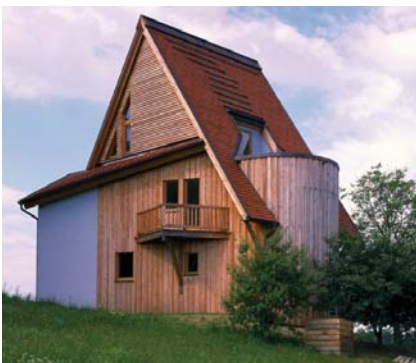
Brennstoffzellen – dezentrale Energieversorgung für Ein- und Mehrfamilienhäuser
