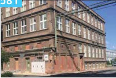
Building No. D581 / Gebäude Nummer D581
