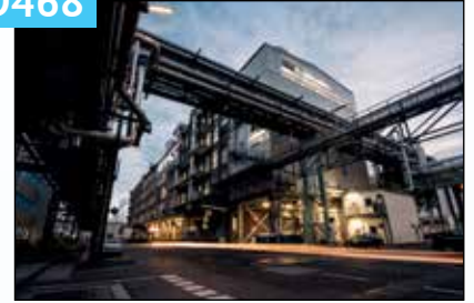
Building No. D468 / Gebäude Nummer D468
